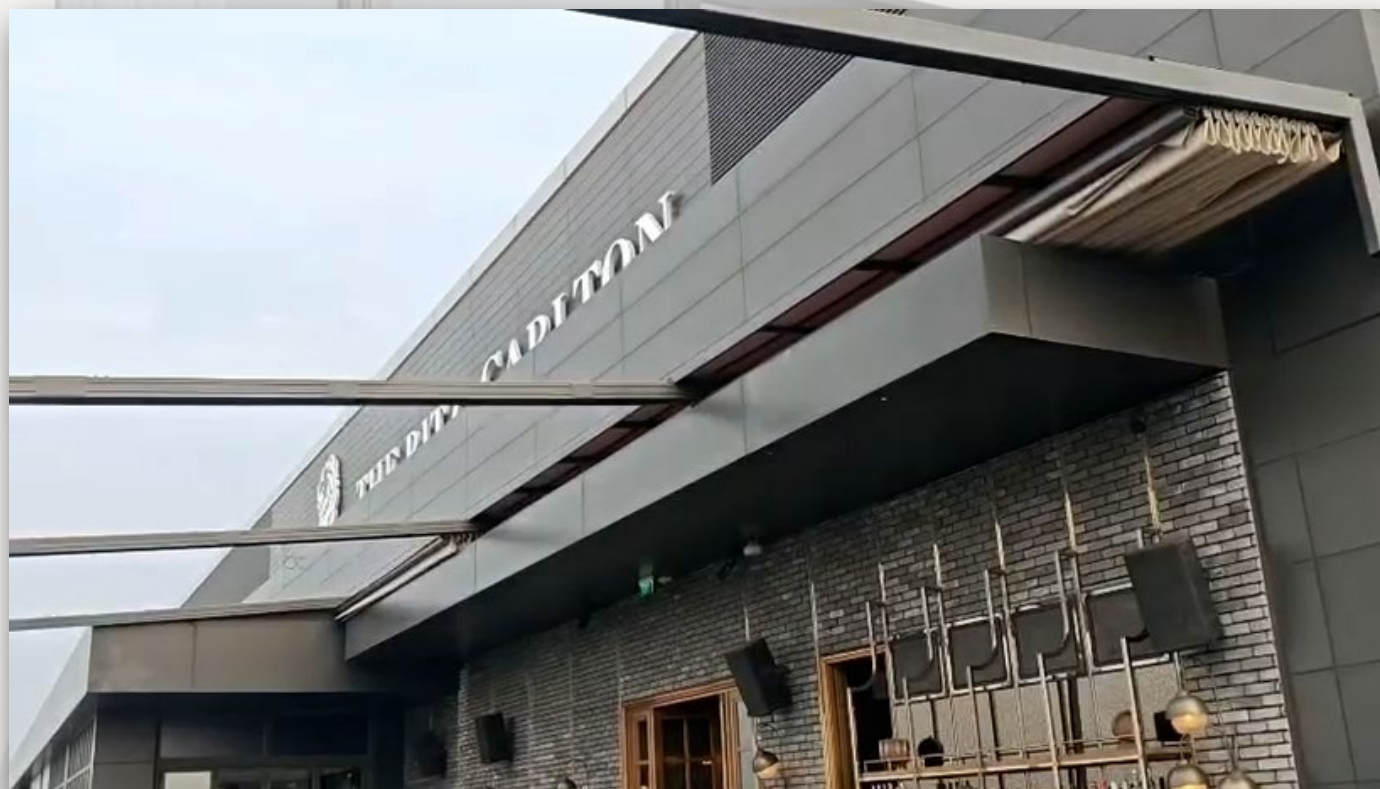
THE RITZ-CARLTON (PUNE)
